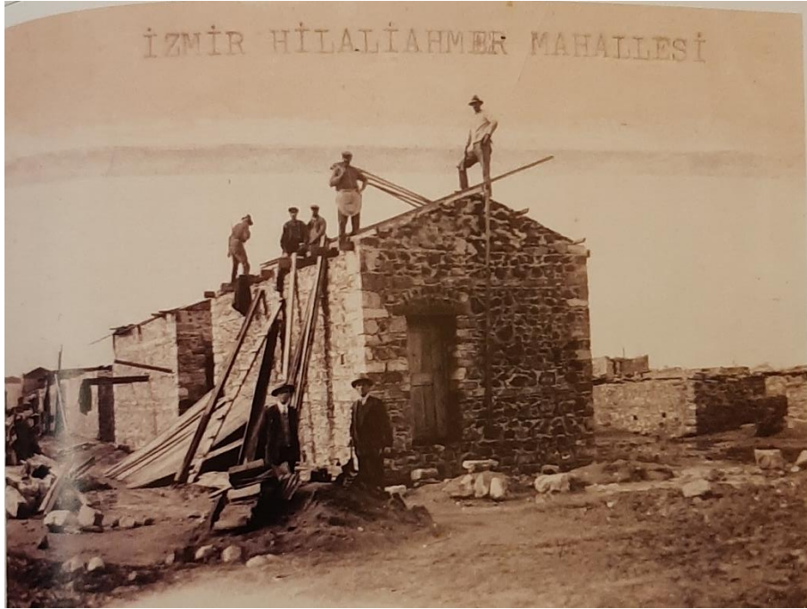
Şekil 4. Sel sonrası inşa edilen evler (Altın, 2016)
