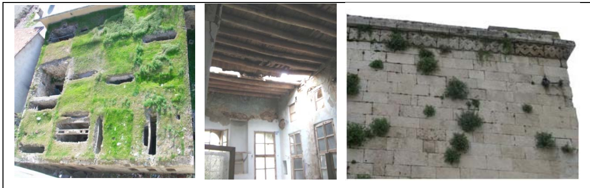
Resim 22. Su ve nemden dolayı görülen bozulmalar
