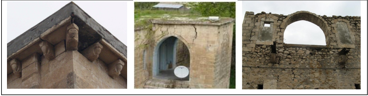
Resim 23. Malzeme deęişiminden dolayı görülen bozulmalar
