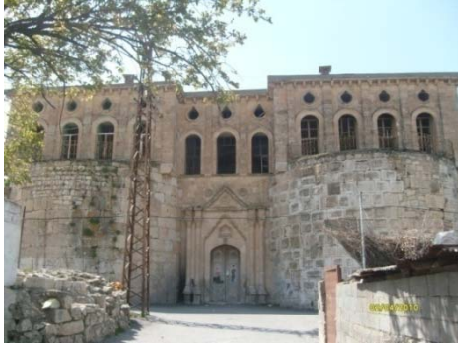
Resim 20. Kale üzerine inşa edilen konut
