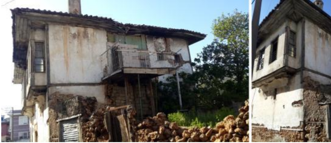
Resim 15: Geniş Saçaklı Kırma Çatı Örneği
