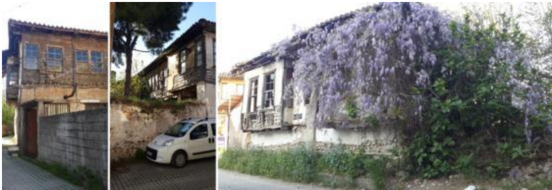
Resim 16: Yığma Taş Üstü Bağdadi Yapım Tekniğinden Örnekler
