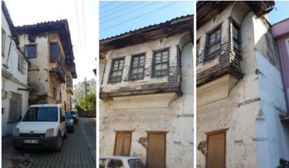
Resim 14: Betonarme Payandalı Cumba Örneği
