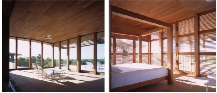
Şekil 18. Sahil Evi, Ahşap Malzeme İle Döşeme Alt Kaplama Uygulaması (URL-5, 2016)
