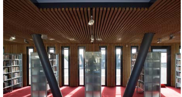
Şekil 12. Rene Goscinny Medyatek'te Ahşap Malzeme İle Döşeme Alt Kaplama Uygulaması (URL-3, 2017)
