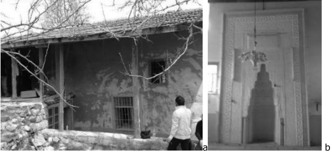
Resim 7-Başayaş Köyü Camii batı cephesi (a) ve mihrabını (b) gösterir fotoğraflar (Kaynak: Yazarlara ait fotoğraf arşivi, 2016).
