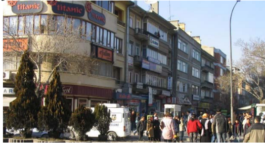
a) Yayalaştırılmadan Önce Cephe Durumu (Korkmaz, 2005)
