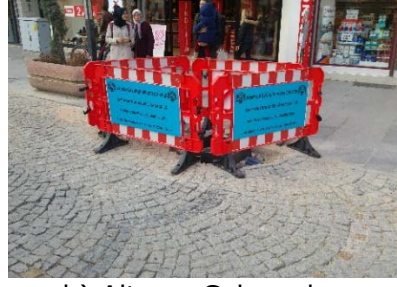
b) Altyapı Çalışmaları
