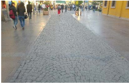
a) Meydan ve Servis Alanı Zemin Kaplaması
