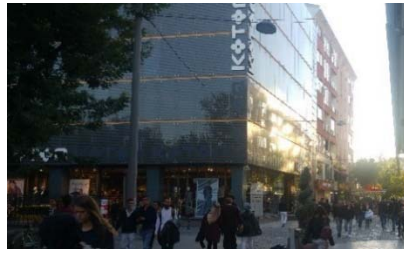
b) Yıkılıp Yeniden Yapılan Binalar
