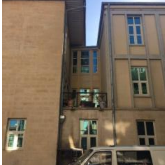
Şekil 40 B - C Blok ara geçiş köprüsü
