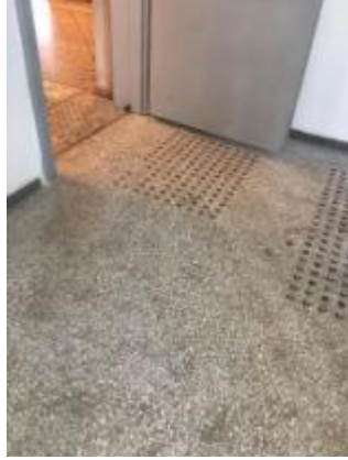
Şekil 69 Özgün dökme döşeme (Güven,E. , 2018)
