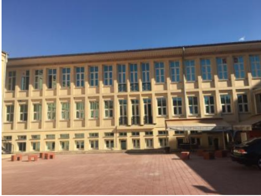
Şekil 43 C Blok iç avlu Cephe Düzeni, Uzun,T.2018
