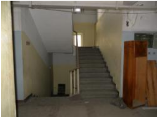
Şekil 41. B Blok merdiven(GA KUDEB)
