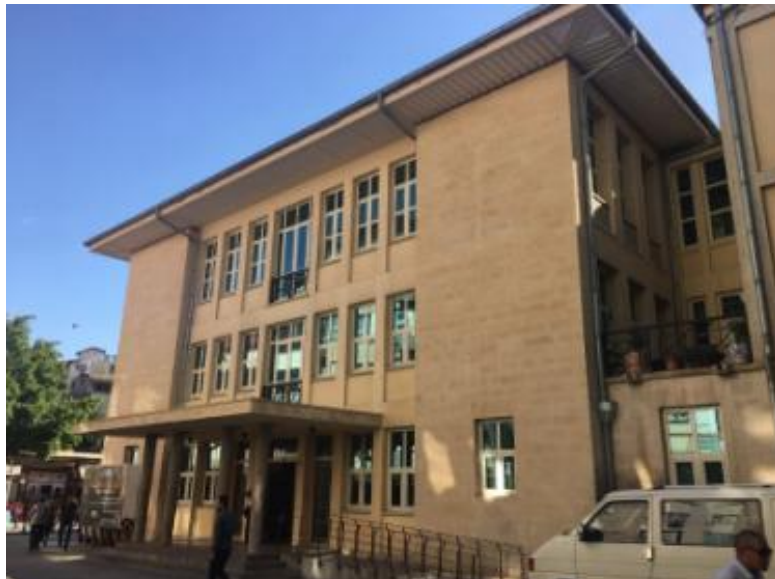
Şekil 57 C Blok arka cephesi ,Dr. Mecit Barlas Caddesi Girişi (Uzun,T. 2018)
