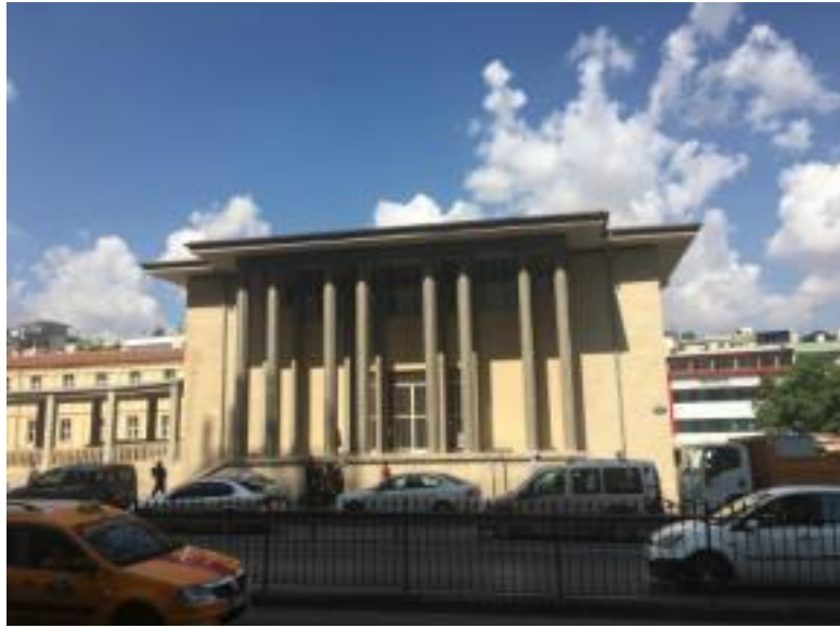
Şekil 56 C Blok Batı Cephesi Girişi, (Uzun,T. 2018)
