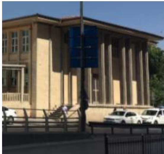
Şekil 51 C Blok Hürriyet caddesi girişi , Batı Cephesi, (Uzun,T.,2018)
