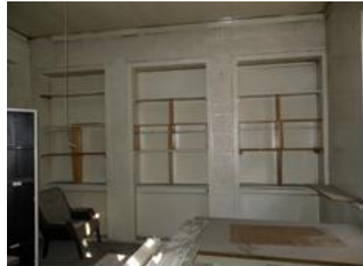
Şekil 42 B Blok Kapatılmış Pencereler(GA KUDEB)
