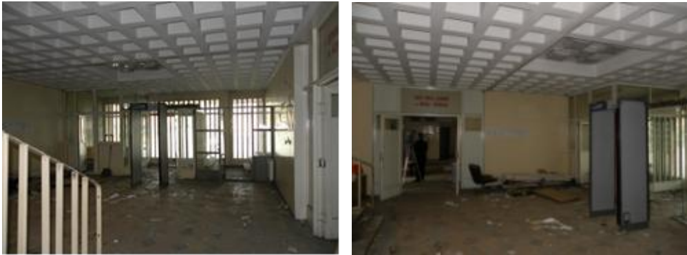
Şekil 36. A Blok içi Giriş Mekanı (GA Kudeb)
