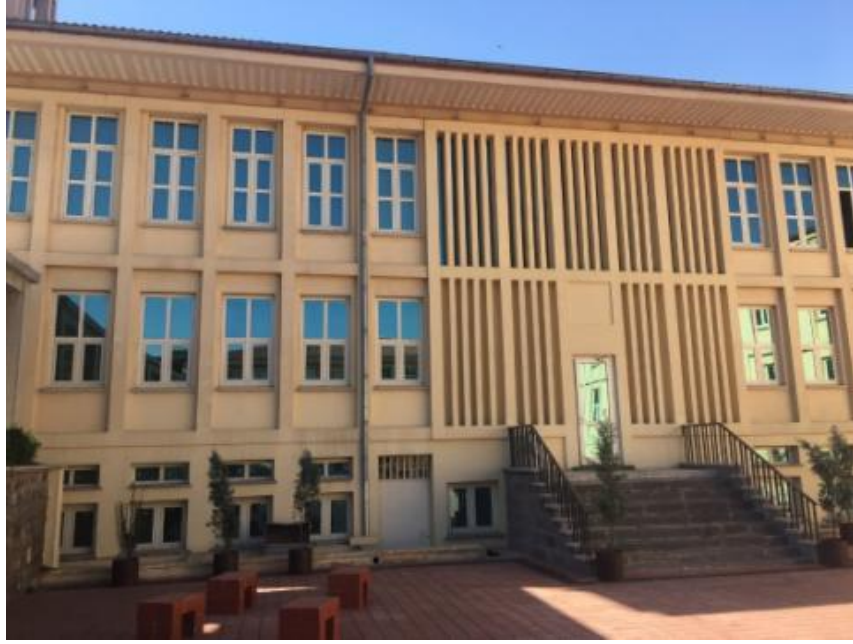
Şekil 37 A Blok avlu girişi ve Cephe düzeni
