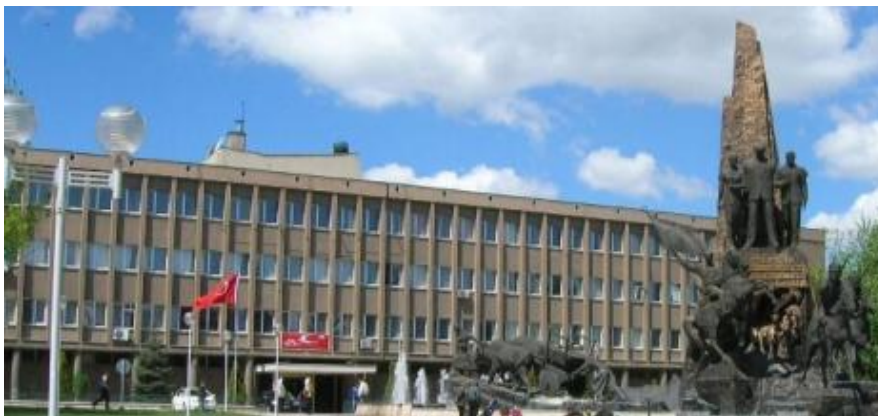
Şekil 15 Uşak Hükümet Konağı 19
