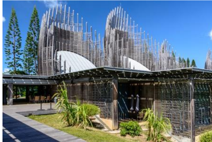
Şekil 3. Yapının Görünüşü (Web 9, 2019).
