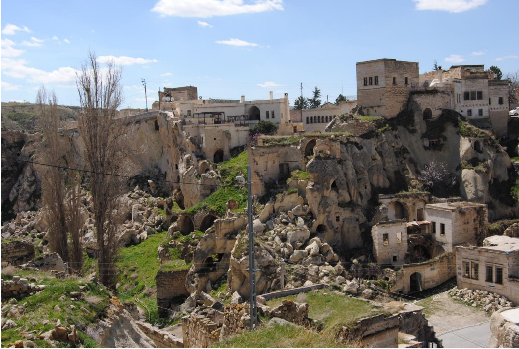
Şekil 2: Ortahisar'da meydana gelen kaya düşmesi
