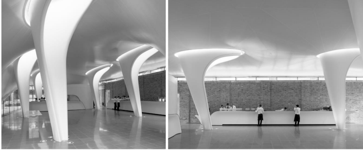
Şekil 4. Serpentine Sackler Galerisi'ne ait eğrisel sütunların membran çatıyla birleşimi. Kaynak: https://www.zaha-hadid.com/interior-design/serpentine-sackler-gallery-2/ adresinden 20.04.2020 tarihinde erişilmiştir.
