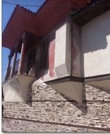
Şekil 8. Sokak cephesine bakan taş ve şakir duvarlı zemin kat
