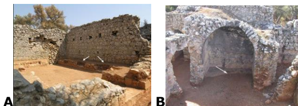
Resim 3.12. A- Soyunmalık mekanını güneydoğu köşesi [15] B-Sıcaklık mekanı batı eyvanı [15]
