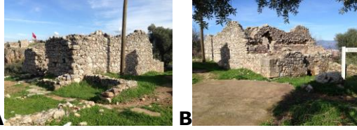
Resim 3.2. A- Ön cephesi [6] B-Arka cephesi [6]
